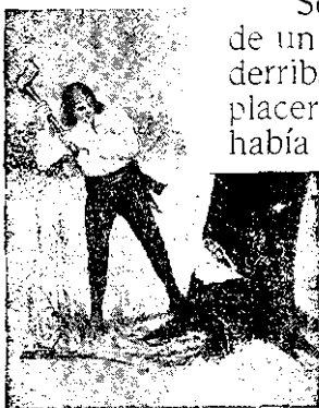
Derribando el árbol
